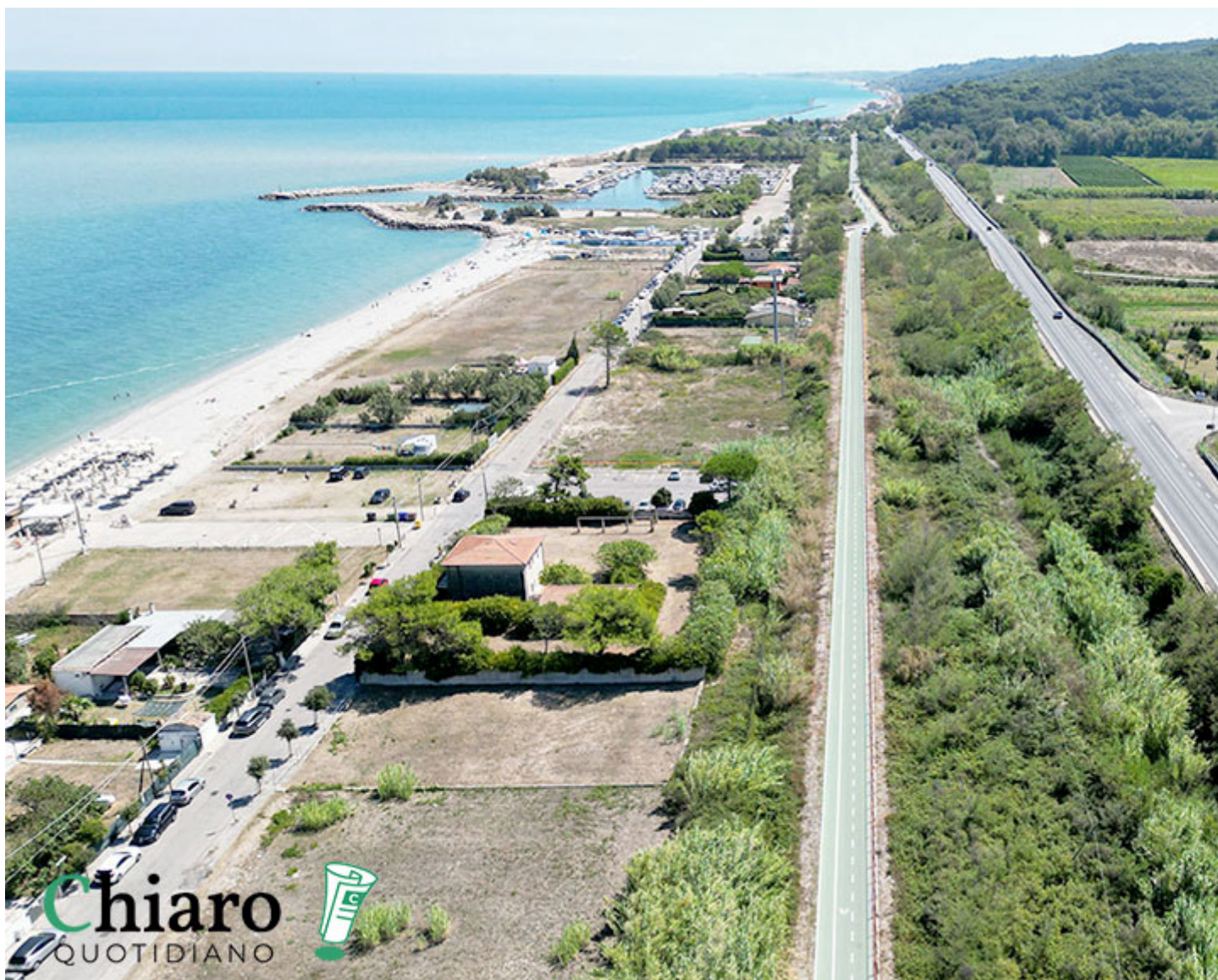
Un tratto della Via Verde a Fossacesia
